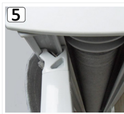
Arm festes til bunnprofil med medfølgende skrue
